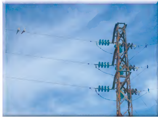
Deux pigeons sur un câble de haute tension
