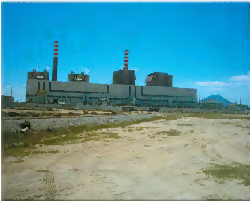
Centrale électrique de Radès - Tunis
