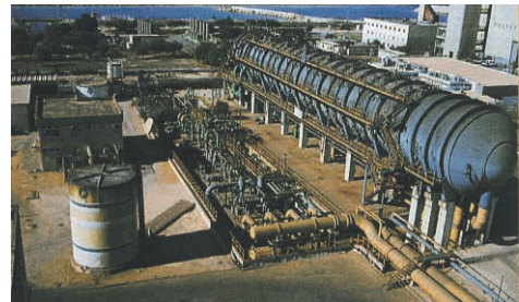
Station de dessalement des eaux de mer dans un pays du Golfe
