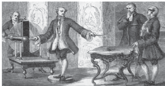
Machine électrostatique de Masden L'isolant sous les pieds de l'opérateur et la décharge entre les deux pointes
